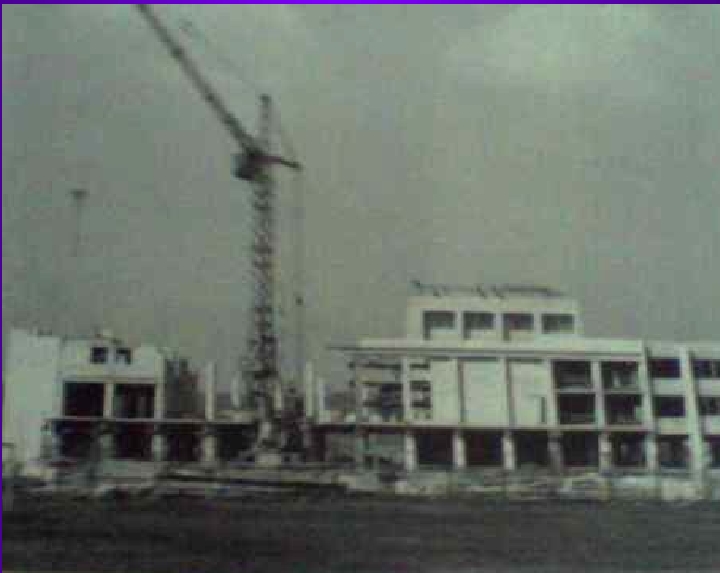
Строительство актового зала, в котором мы находимся. 1974 год.
